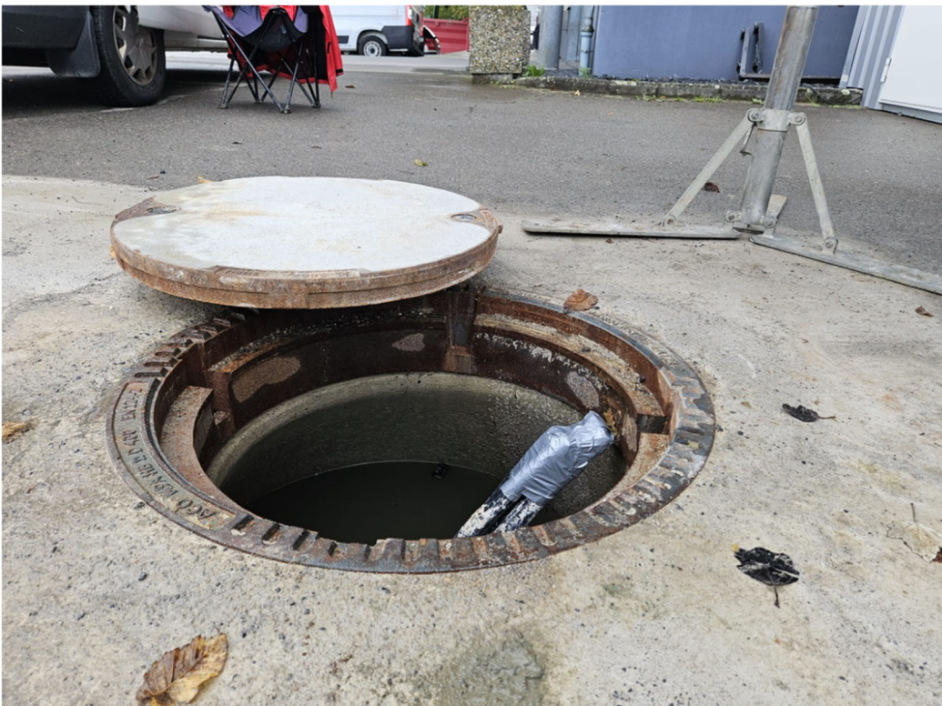
Foto 2: Erdwärmesonde nach Abbau des Geothermal Response Tests
